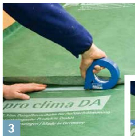
Dans le système pro clima DA connect, le collage des chevauchements se fait avec les deux zones autocollantes intégrées. Les chevauchements des lés pro clima DA ainsi que les joints aux extrémités se collent à l'aide du ruban adhésif double face pro clima DUPLEX ou simple face TESCON No.1 ou TESCON VANA. Bien frotter les rubans pour qu'ils adhèrent au support, p. ex. à l'aide de la spatule de fixation pro clima PRESSFIX.
