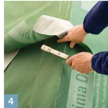
Centrer une bande de DA d'une largeur d'env. 40 cm sur le faîtage. En agraffer les bords. Ensuite, réaliser le collage étanche à l'air à l'aide du ruban adhésif TESCON No.1 ou TESCON VANA. Recouvrir également les agrafes de ruban adhésif. Bien frotter les rubans pour qu'ils adhèrent au support.
