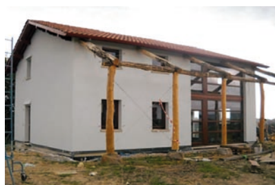
Projet à Arbonne (64) dans les Pyrénées Atlantique. Iso- lation Système UdiFRONT Épaisseur 200 mm avec enduit UdiPERL, grain 1.5 mm.
