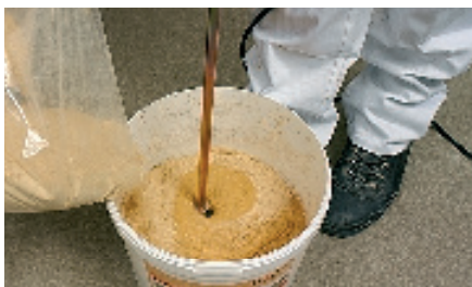
Mélange de la poudre avec de l'eau, laisser reposer 30 minutes.
